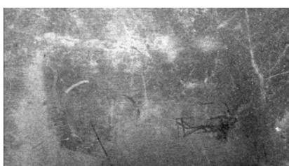
●コントラスト強調処理
